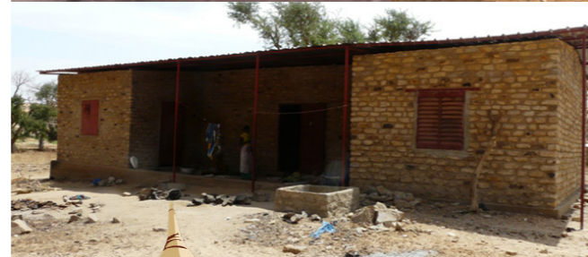
Construction d'un centre de santé (Nombori)
